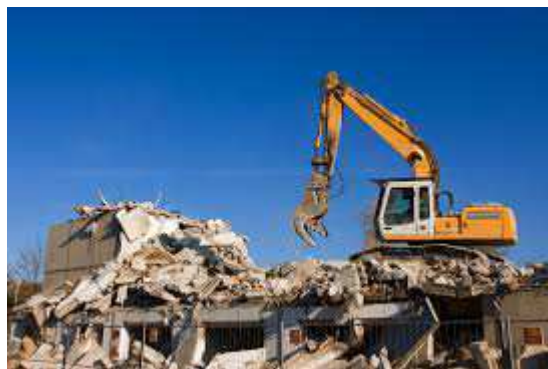
Projection du chantier DGFIP après préconisations de la Cour des comptes sous couvert de CAP 2022...
